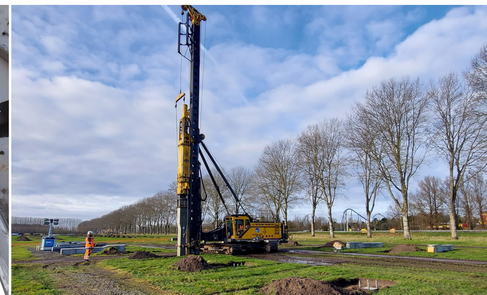
Junttan piling rig PMx22 installing centrum piles
